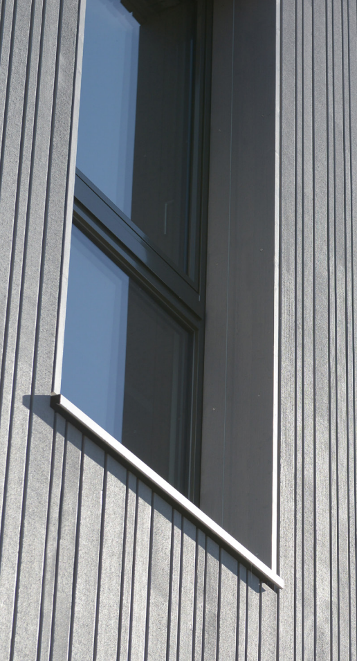
Bürogebäude OLWO in Worb (Aussenschalung CH-Tanne keilgezinkt, astfrei, mit Farbbehandlung vorvergraut)
