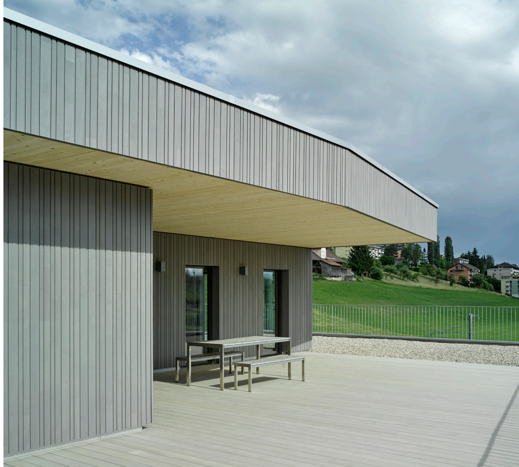
Bürogebäude OLWO in Worb (Aussenschalung CH-Tanne keilgezinkt, astfrei, mit Farbbehandlung vorvergraut)
