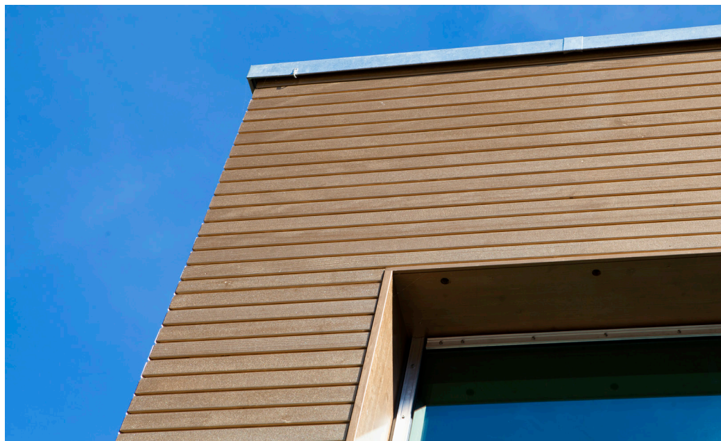
Kindergarten in Interlaken (Aussenschalung, CH-Tanne keilgezinkt, strukturfein, astfrei, mit Farbbehandlung)
