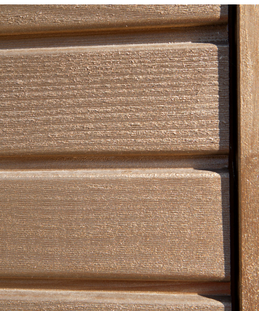
Jardin d'enfants à Interlaken (bardage en sapin suisse abouté, structure fine, sans nœuds, avec traitement de coloration)
